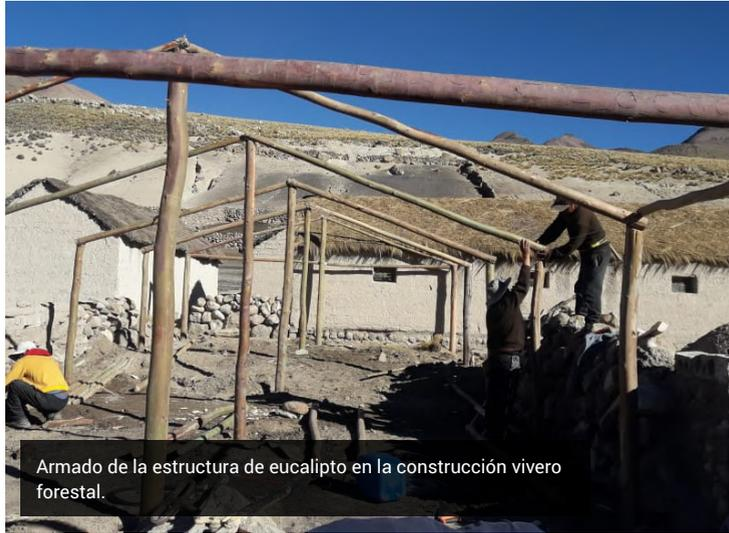
Armado de la estructura de eucalipto en la construcción vivero forestal.
