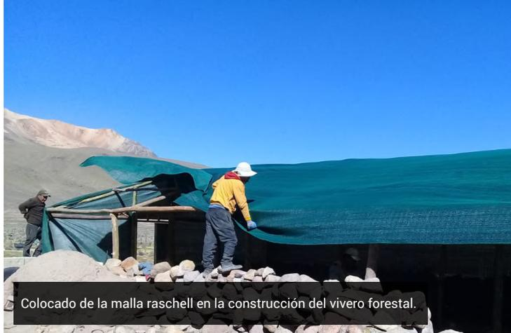
Colocado de la malla raschell en la construcción del vivero forestal.
